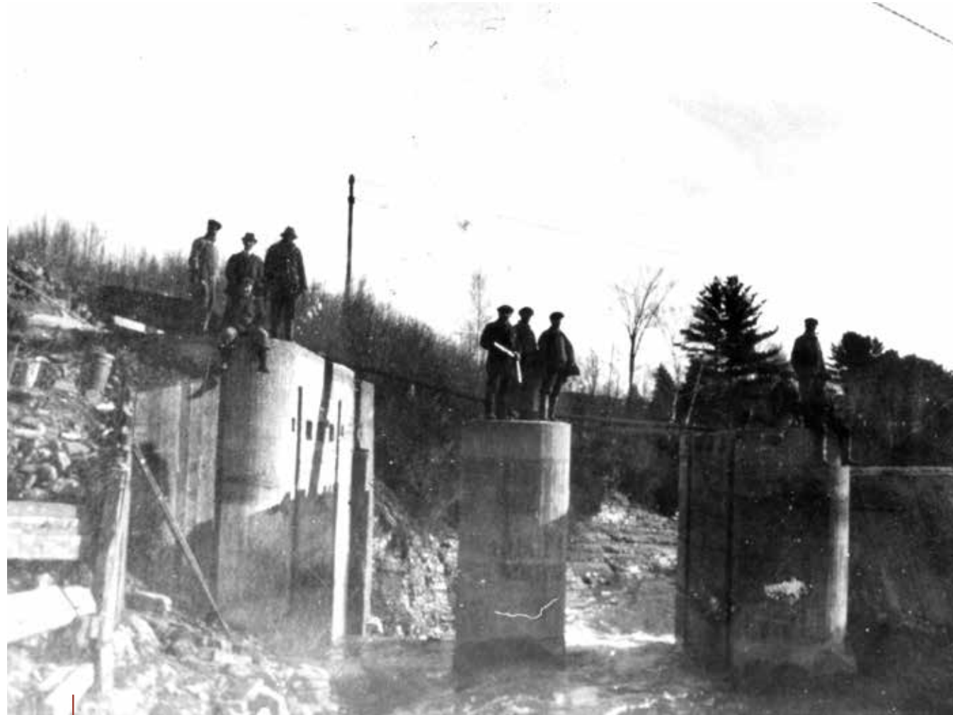
CONSTRUCTION DES PILIERS DU BARRAGE HYDRO-ÉLECTRIQUE DE JOLIETTE sur la rivière L'Assomption. Aujourd'hui, ces structures supportent la passerelle de La Sérénade. Source : Collection Jean Chevrette photographe.
