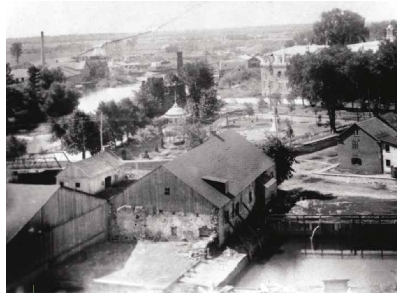
LE GRAND MOULIN , partiellement détruit par un incendie, peu de temps avant sa démolition complète (vers 1912). Source : Société d'histoire de Joliette - De Lanaudière.
