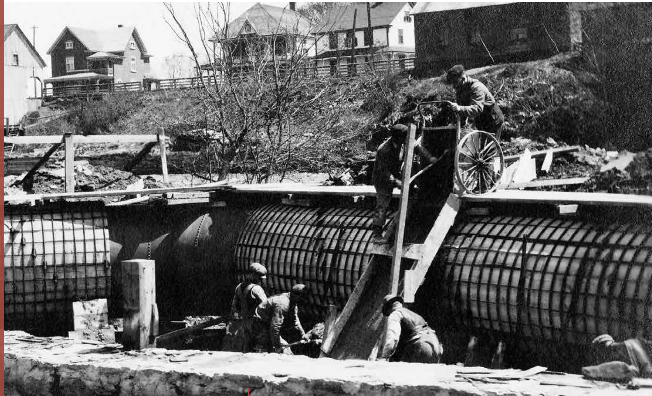
AMÉNAGEMENT DE LA CONDUITE D'EAU SOUTERRAINE DESTINÉE À ALIMENTER L'USINE DE FILTRATION ET SA CENTRALE HYDRO-ÉLECTRIQUE (8 mai 1915). Source : Coll. privée.
