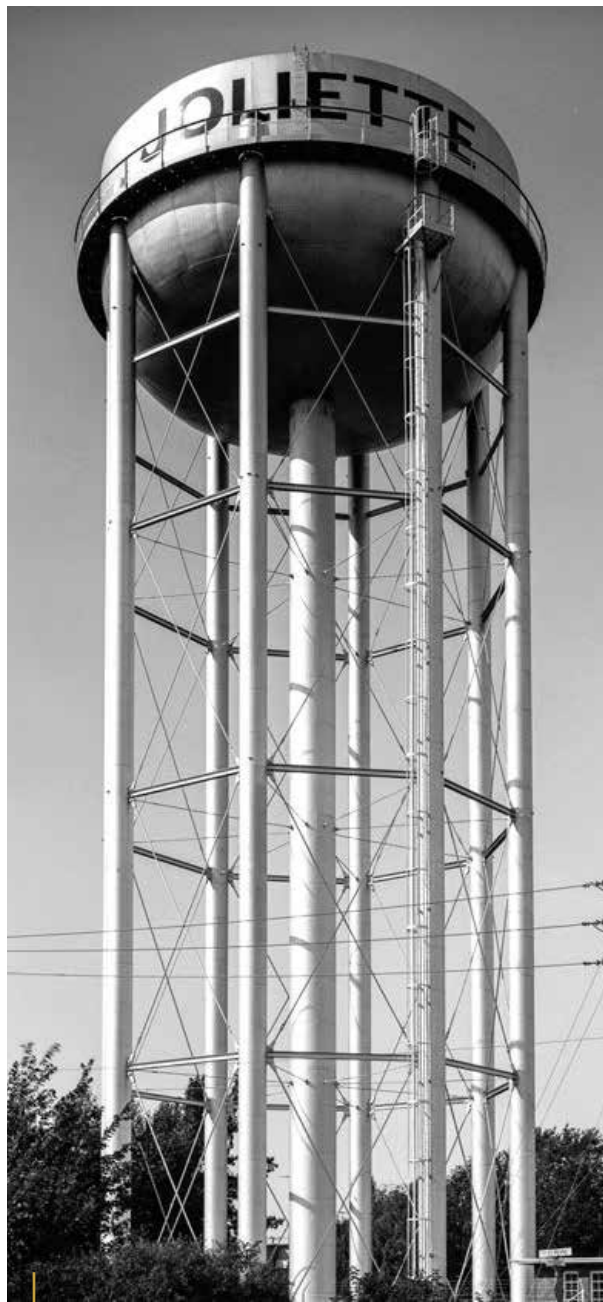
RÉSERVOIR (CHÂTEAU D'EAU) DE LA VILLE DE JOLIETTE, à l'usage de la compagnie « Pinatel Piece Dye Works », autrefois situé à l'intersection des rues Richard et Saint-Pierre Nord (vers 1975). Source : Coll. privée.
