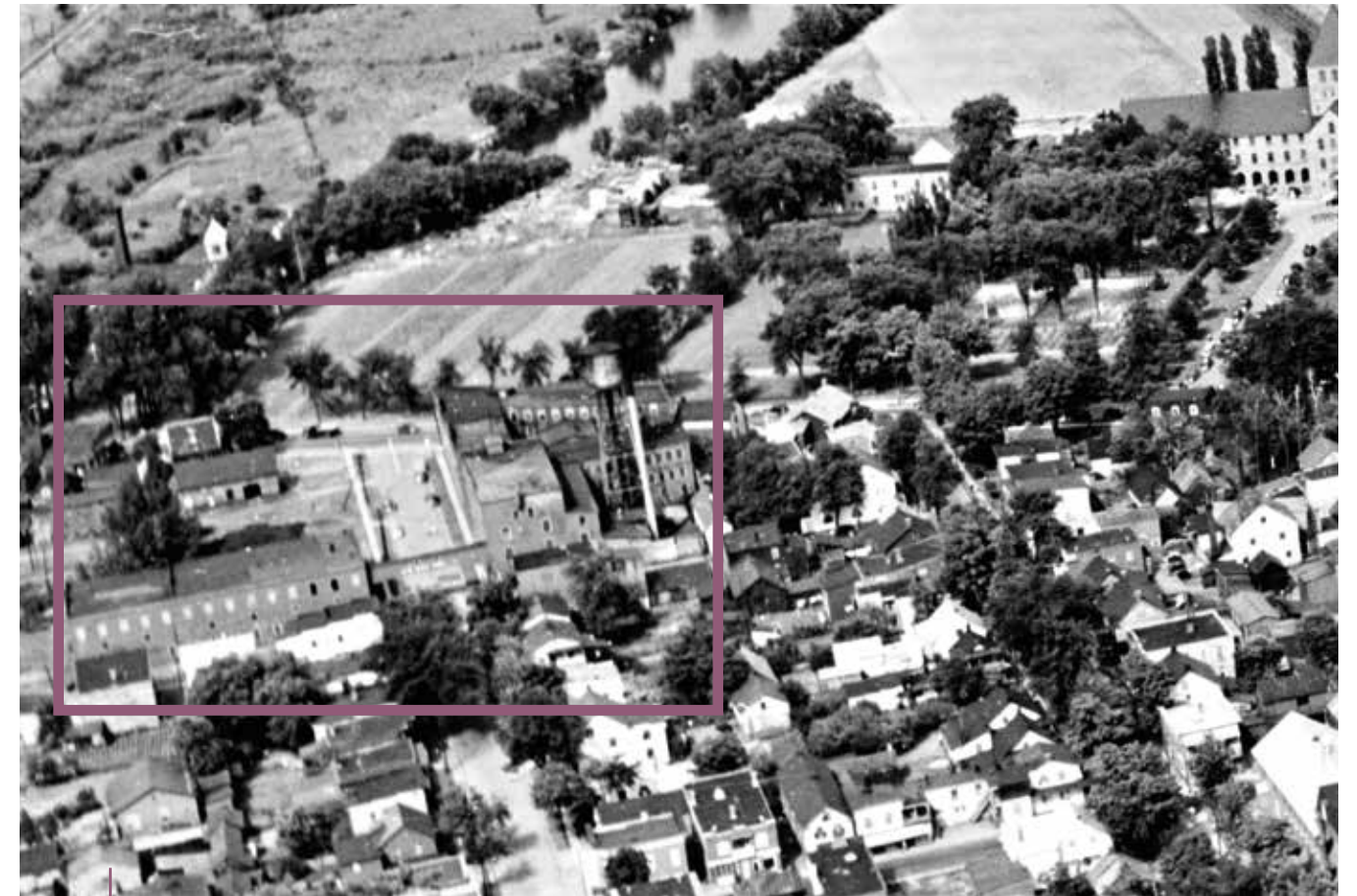
VUE AÉRIENNE DES INSTALLATIONS DE L'« ACME GLOVE WORKS » (1948). Source : Coll. privée.
